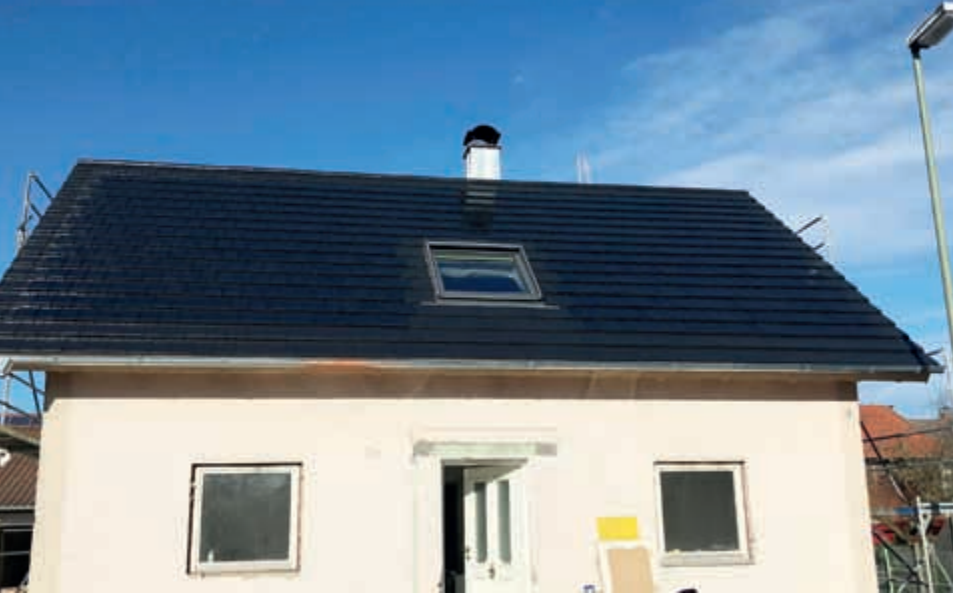
Eine 5,5-kW-Anlage mit Autarq-Solardachziegeln in Buchloe/Bayern, die im Zuge einer Generalsanierung gebaut wurde.
