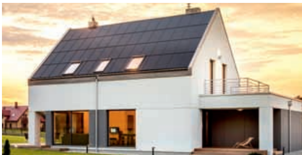
Die Solardachlösung ersetzt ein herkömmliches Dach und versorgt hier ein privates Wohnhaus mit Energie.
