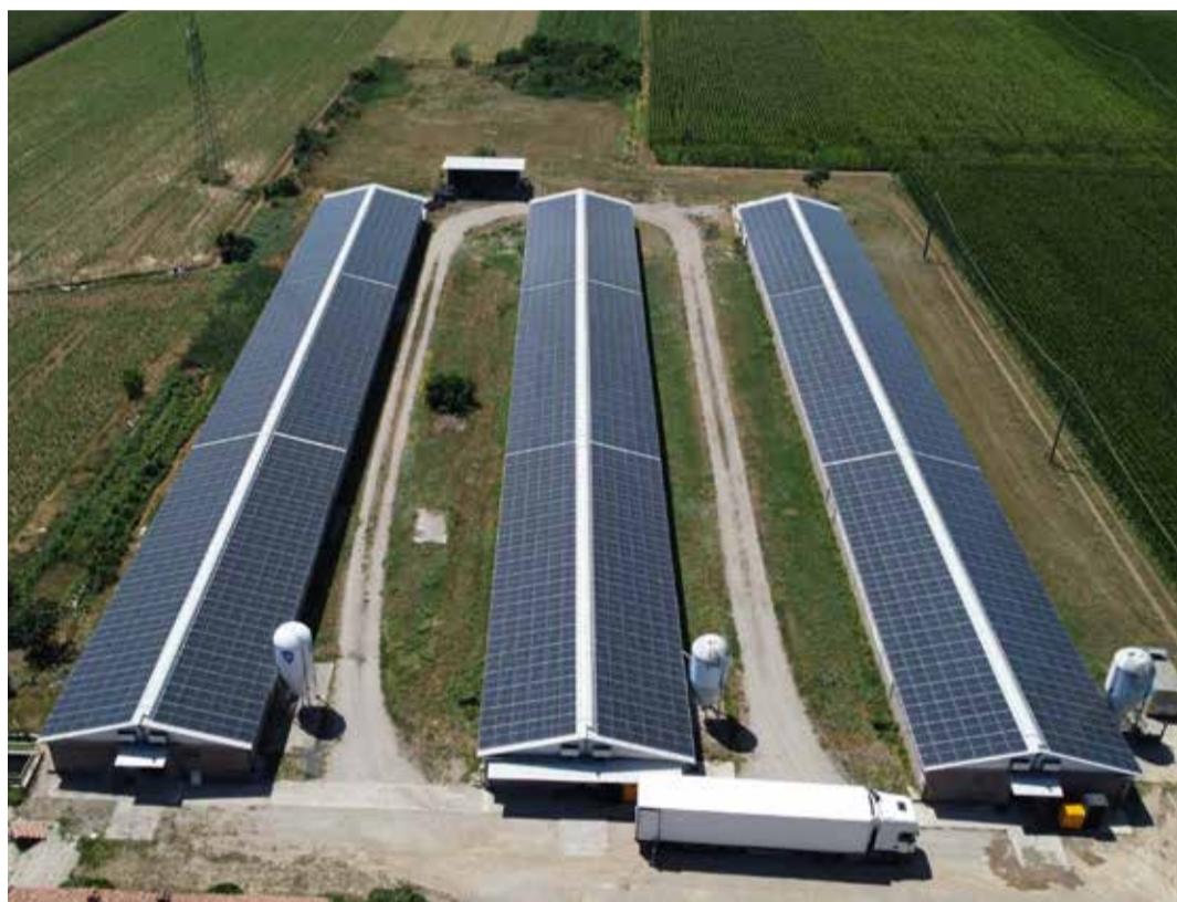
L'IMPIANTO PER L'AZIENDA AGRICOLA ALTERNATIVE È STATO INSTALLATO SU DUE CAPANNONI E HA UNA POTENZA TOTALE DI 819 KWP. CONSISTE IN 2.200 PANNELLI LONGI SOLAR DA 375 WP E DA UN GRUPPO DI CONVERSIONE COMPOSTO DA 8 INVERTER SG110CX SUNGROW
