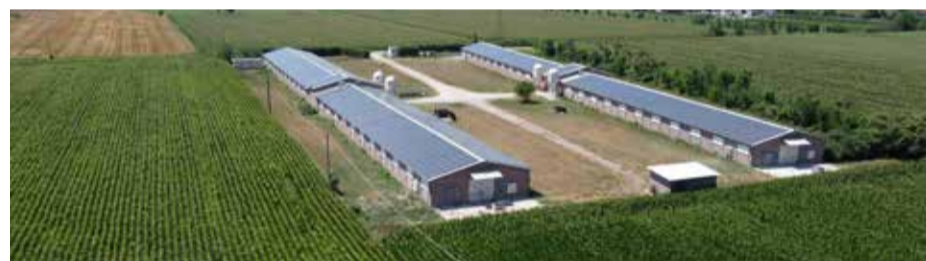
L'IMPIANTO PER L'AZIENDA AGRICOLA PARELIO È STATO INSTALLATO SU DUE CAPANNONI E HA UNA POTENZA TOTALE DI 819 KWP. CONSISTE IN 2.184 PANNELLI LONGI SOLAR DA 375 WP E DA UN GRUPPO DI CONVERSIONE COMPOSTO DA 8 INVERTER SG110CX SUNGROW.
