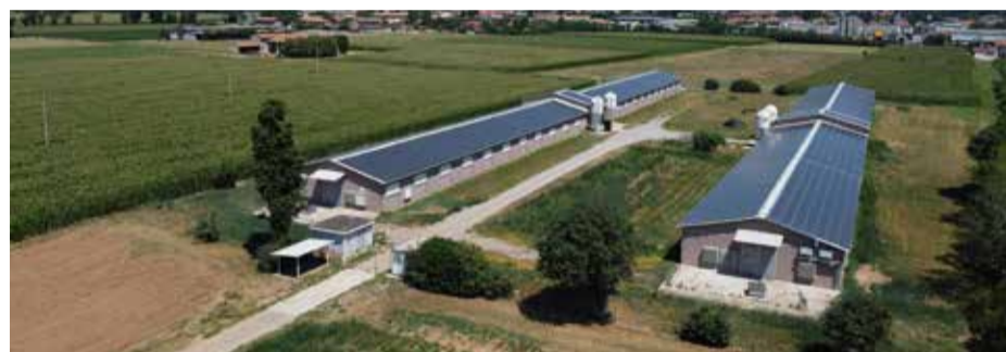
L'IMPIANTO PER L'AZIENDA AGRICOLA ALTERNATIVE È STATO INSTALLATO SU DUE CAPANNONI E HA UNA POTENZA TOTALE DI 819 KWP. CONSISTE IN 2.200 PANNELLI LONGI SOLAR DA 375 WP E DA UN GRUPPO DI CONVERSIONE COMPOSTO DA 8 INVERTER SG110CX SUNGROW
