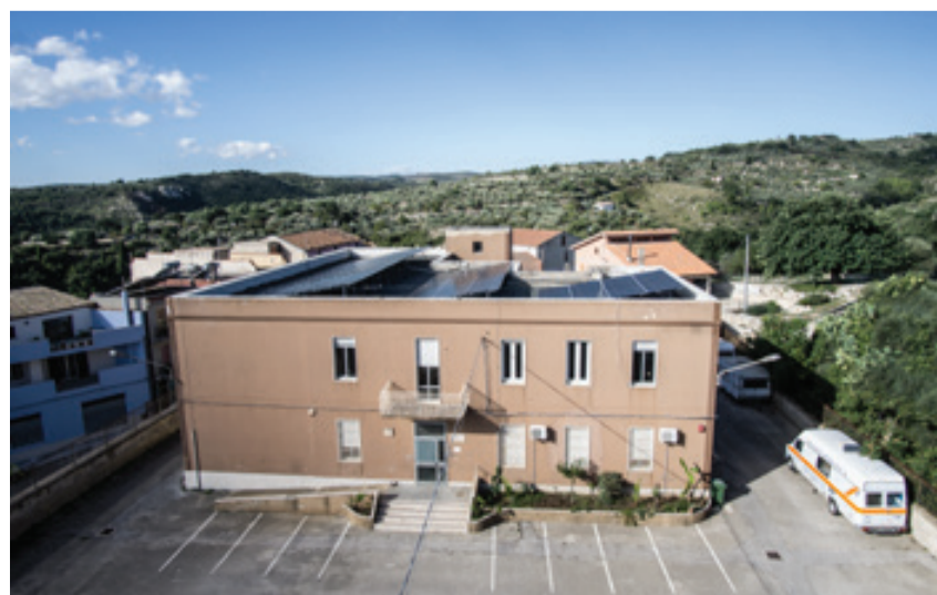
LA SCUOLA ELEMENTARE DI FERLA OSPITA UN IMPIANTO DA 80 KW. È IL PIÙ GRANDE FRA TUTTE LE INSTALLAZIONI FOTOVOLTAICHE REALIZZATE SUGLI EDIFICI DEL COMUNE
