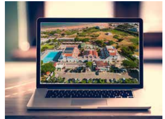
L'INTERVENTO CHE HA INTERESSATO L'HOTEL D'AMATO DI PESCHICI (FG) HA VISTO L'INSTALLAZIONE DI SOLARE TERMICO, IMPIANTO FOTOVOLTAICO E POMPE DI CALORE
