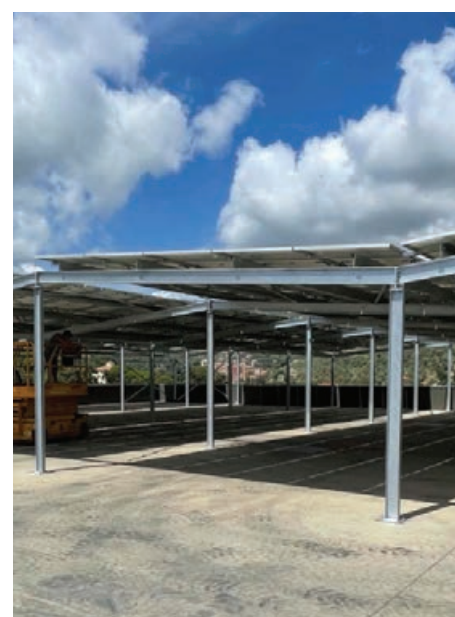
L'IMPIANTO, COSTITUITO DA MODULI AD ALTA POTENZA JA SOLAR, INVERTER SUNGROW E SISTEMI DI MONTAGGIO RCM, POTREBBE PRODURRE OGNI ANNO 600 MWH DI ENERGIA PULITA. L'80% VERRÀ AUTOCONSUMATA
