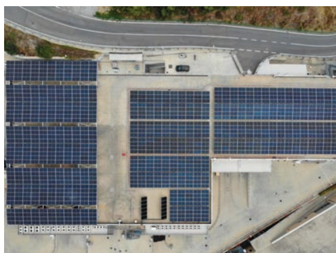
L'IMPIANTO, COSTITUITO DA MODULI AD ALTA POTENZA JA SOLAR, INVERTER SUNGROW E SISTEMI DI MONTAGGIO RCM, POTREBBE PRODURRE OGNI ANNO 600 MWH DI ENERGIA PULITA. L'80% VERRÀ AUTOCONSUMATA
