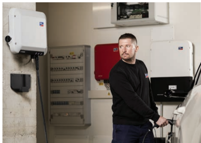
L'ABITAZIONE È DOTATA DI IMPIANTO FOTOVOLTAICO DA 3,8 KWP CON MODULI TRIENERGIA, ALLACCIATI A UN INVERTER SMA SUNNY BOY DA 4 KWP. È PRESENTE INOLTRE UN SISTEMA DI ACCUMULO PER IMPIANTI RESIDENZIALI COSTITUITO DA INVERTER SUNNY BOY STORAGE 3.7 E BATTERIA AD ALTO VOLTAGGIO LG CHEM, OLTRE A UN SISTEMA DI RICARICA SMA EV CHARGER PER I VEICOLI ELETTRICI
