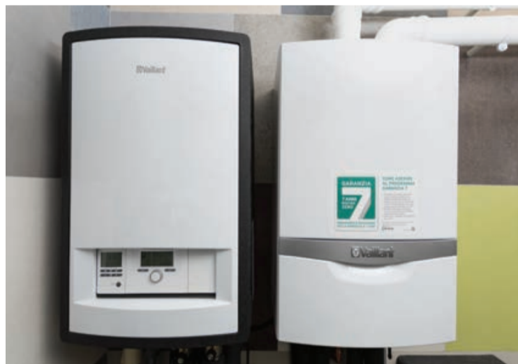
PER LA PARTE TERMICA, È STATA INSTALLATA UNA POMPA DI CALORE CON CALDAIA A CONDENSAZIONE VAILLANT. A OTTIMIZZARE IL DIALOGO TRA IMPIANTO FOTOVOLTAICO, IMPIANTO TERMICO E DOMOTICA, CI PENSA IL SUNNY HOME MANAGER 2.0, FORNITO DA SMA
