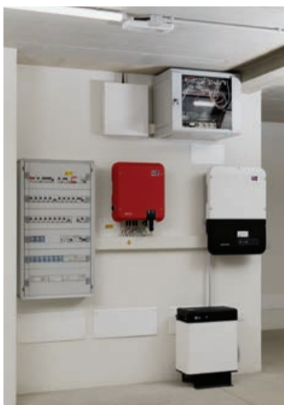
L'ABITAZIONE È DOTATA DI IMPIANTO FOTOVOLTAICO DA 3,8 KWP CON MODULI TRIENERGIA, ALLACCIATI A UN INVERTER SMA SUNNY BOY DA 4 KWP. È PRESENTE INOLTRE UN SISTEMA DI ACCUMULO PER IMPIANTI RESIDENZIALI COSTITUITO DA INVERTER SUNNY BOY STORAGE 3.7 E BATTERIA AD ALTO VOLTAGGIO LG CHEM, OLTRE A UN SISTEMA DI RICARICA SMA EV CHARGER PER I VEICOLI ELETTRICI
