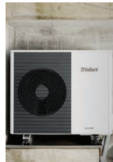
PER LA PARTE TERMICA, È STATA INSTALLATA UNA POMPA DI CALORE CON CALDAIA A CONDENSAZIONE VAILLANT. A OTTIMIZZARE IL DIALOGO TRA IMPIANTO FOTOVOLTAICO, IMPIANTO TERMICO E DOMOTICA, CI PENSA IL SUNNY HOME MANAGER 2.0, FORNITO DA SMA
