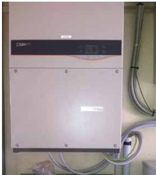
LA RICERCA DI PEZZI DI RICAMBIO DEL VECCHIO INVERTER AVREBBE COMPORTATO UNA SPESA MAGGIORE RISPETTO ALLA COMPLETA SOSTITUZIONE
