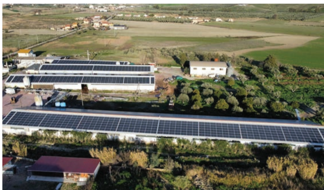
IMPIANTO FOTOVOLTAICO DA 568,48 KWP A CUTRO (KR), INSTALLATO A SEGUITO DI SMALTIMENTO AMIANTO E RIFACIMENTO COPERTURA CON INCENTIVI DECRETO FER
