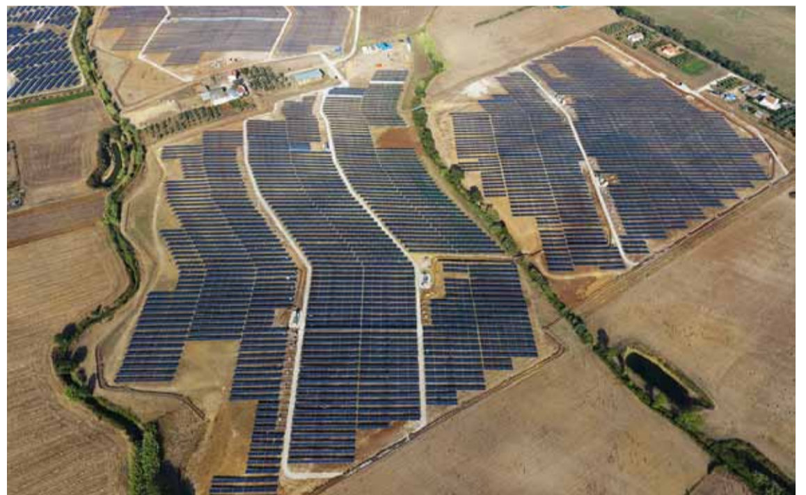
LE CENTRALI FV REALIZZATE E ALLACCIATE LO SCORSO APRILE A MONTALTO DI CASTRO (VT), PER UN TOTALE DI 64 MWp, SONO UNO DEI PRIMI ESEMPI DI GRID PARITY IN ITALIA
