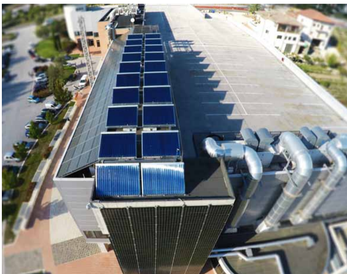
UN IMPIANTO SOLARE TERMICO REALIZZATO PER UN CENTRO SPORTIVO CON PISCINE NEL SUD ITALIA. L'INSTALLAZIONE È COSTITUITA DA UN IMPIANTO SOLARE TERMICO DI 99,80 MQ PER LA SOLA PRODUZIONE DI ACQUA CALDA SANITARIA, CON 20 COLLETTORI HEATPIPE E DUE ACCUMULI DA 2.000 LITRI CHE SERVIRANNO COME PRERISCALDO ALL'IMPIANTO ESISTENTE
